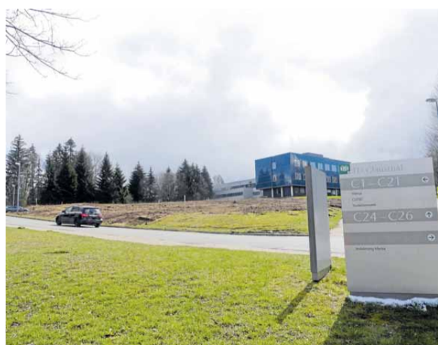
An der Kreuzung von Agricolastraße und Walther-Nernst-Straße auf dem TU-Campus beginnen bald die Bauarbeiten für das neue Gründungszentrum. Foto: Römhild
